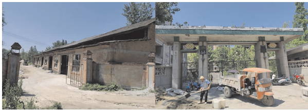
图5 下溢水村内“无人管”地带
